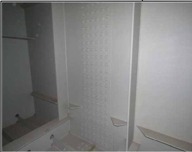
내 용 S2 G2 우측면 SPLICE 상태양호
