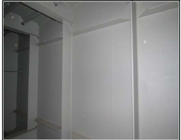
내 용 S2 G2 우측면 수직보강재 상태양호
