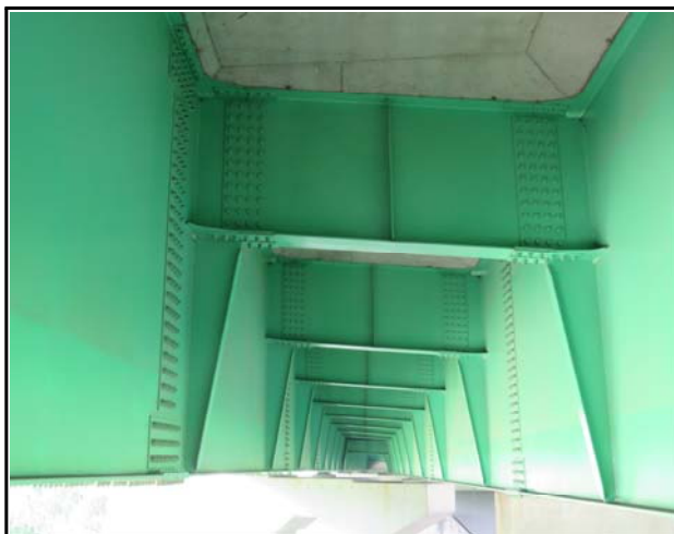
내 용 바닥판하면 가로보 전경
