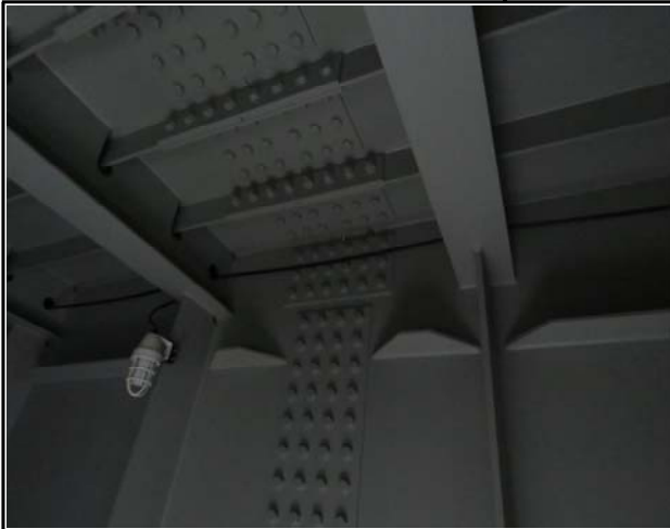
내 용 S3 G3 상면 SPLICE 상태양호
