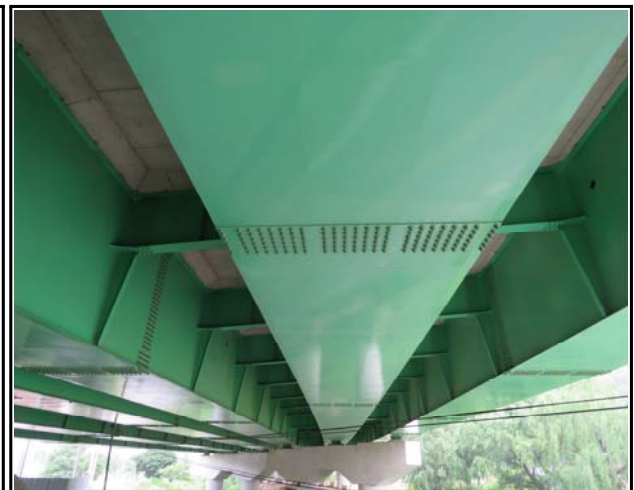
내 용 바닥판하면 전경
