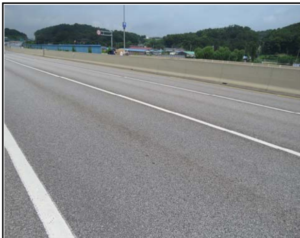
내 용 교면포장 전경
