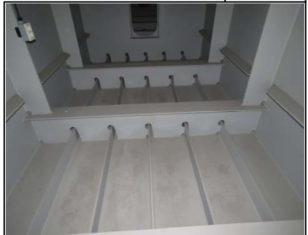
내 용 S1 G2 하부플랜지 정리부 상태양호
