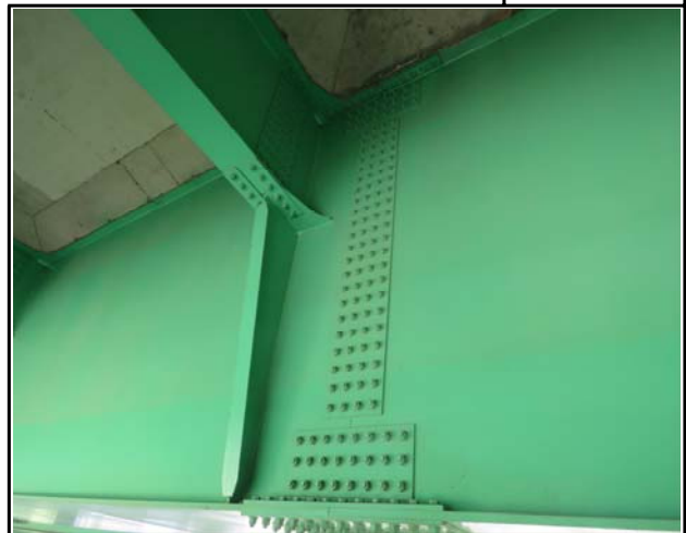
내 용 S2 G3 SPLICE 전경
