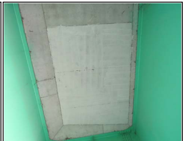
내 용 Deck plate 전경
